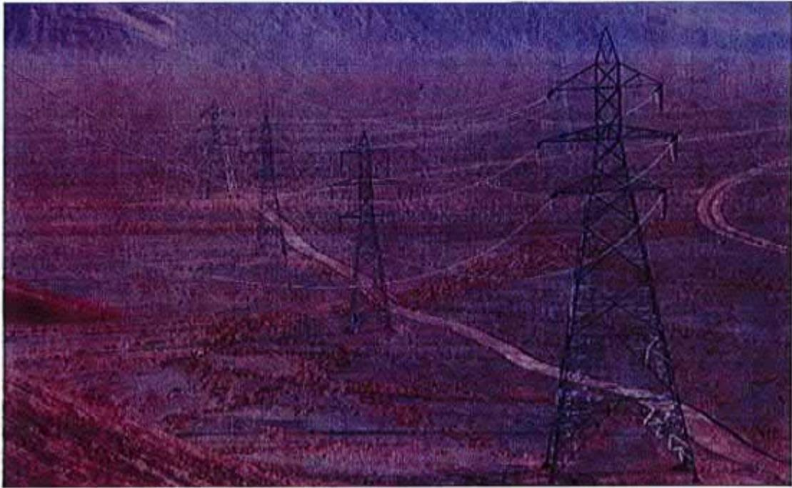
خط انتقال دو مداره با سطح ولتاژ ۲۳۰ کیلو ولت
